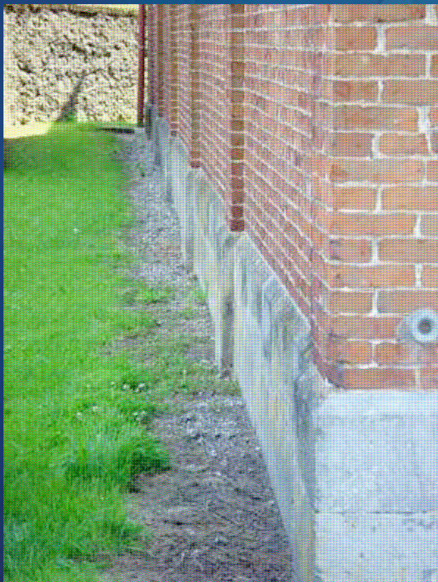
Pied de mur Eglise
