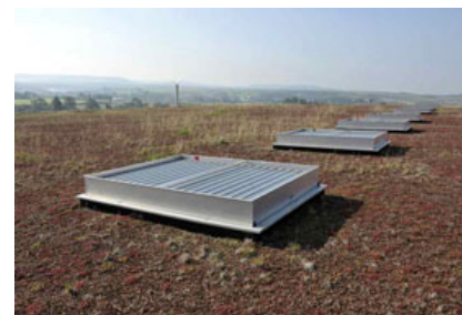
Toiture végétalisée - Ecover
