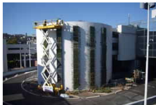
Installation de murs végétalisés
