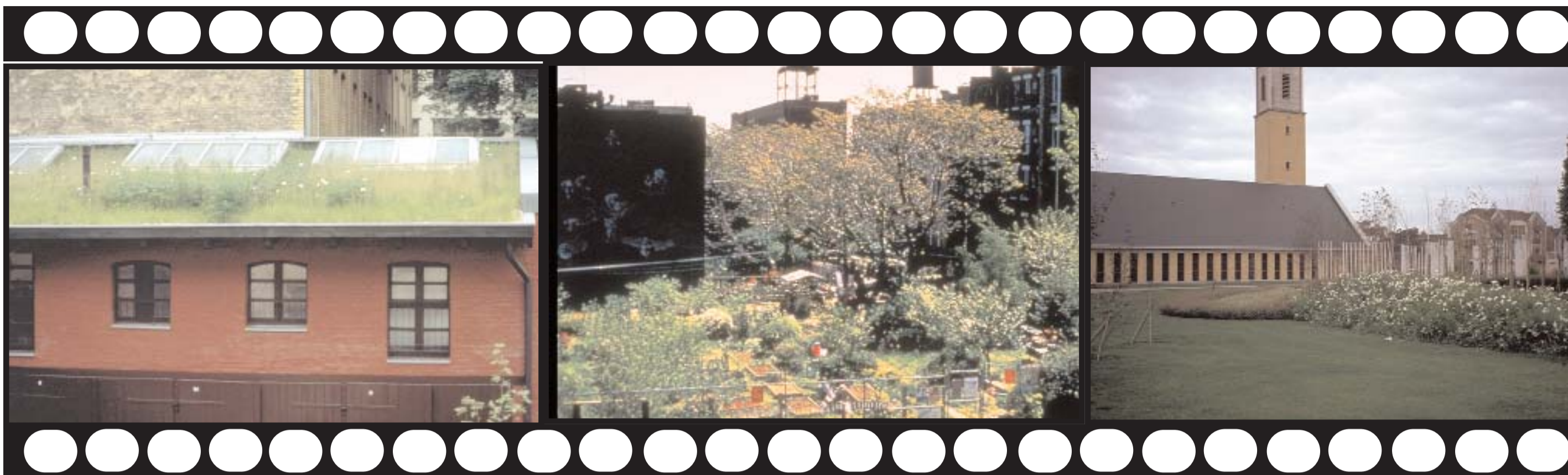
Toiture verdie d'un particulier
