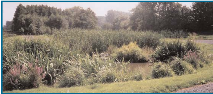
Station de lagunage d'Amfroipret, premier bassin à macrophytes (roseaux, massettes...). septembre 2001
