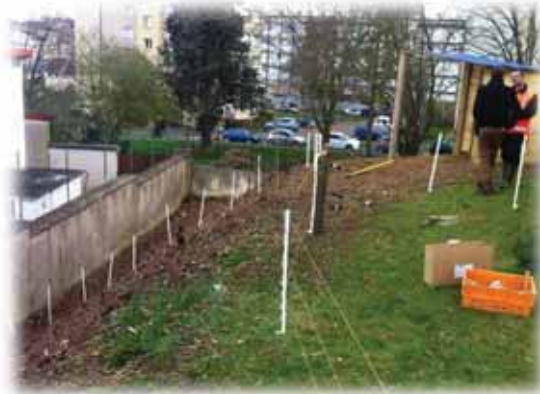
Figure 8 : Mise en place de la clôture
