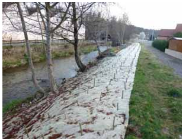
Figure 8 : Bouturage sur géotextile au Val d'Ajol en 2012 [19]
