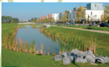
Bassin de rétention d'eau
