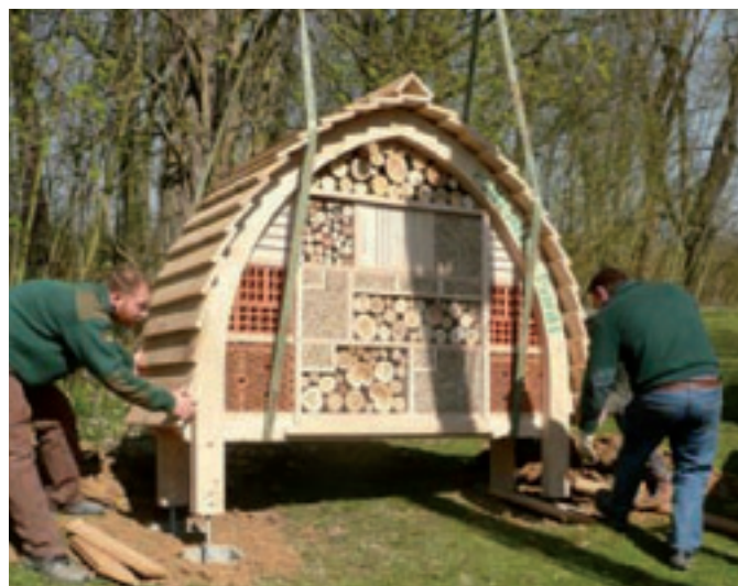
Installation d'un hotel
