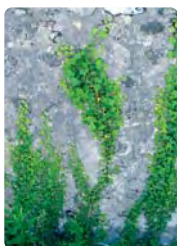
Vieux mur fleuri
