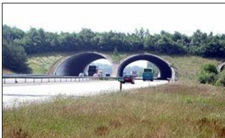
Photo 22 : Ecoduc de type « supérieur » (car aménagé au dessus de la route) aménagé pour favoriser les déplacements des cervidés (= cerviduc).
