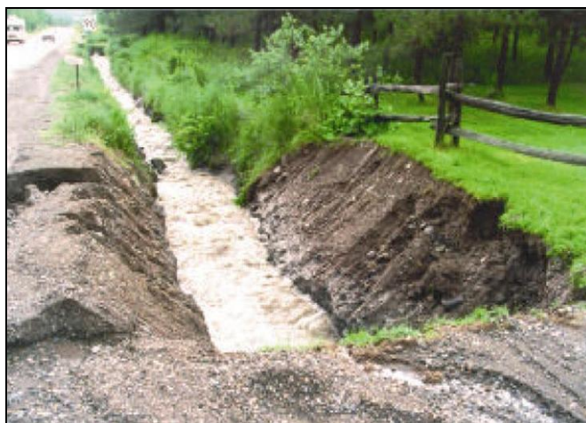
Photo 17 : Comparaison entre un fossé curé de manière classique (1 er plan) et selon la méthode du tiers inférieur (2 nd plan). Notez l'érosion du talus *
