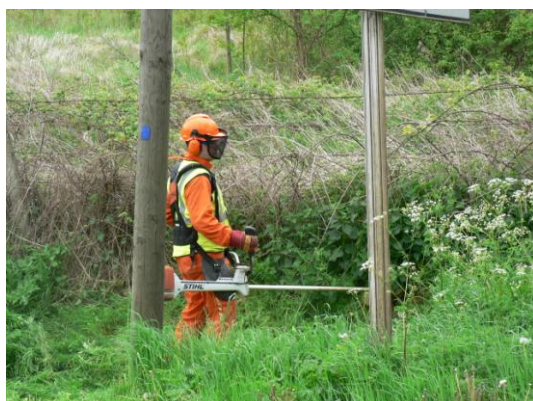
Photo 10 : nettoyage autour des poteaux effectué à la débroussailleuse par la DIR de Seine-et-Marne.
