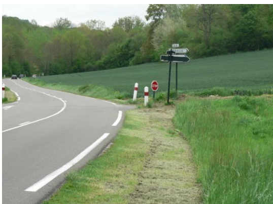
Photo 12 : tonte différenciée en bordure de route, avec aménagement d'une bande de déambulation et dégagement de visibilité aux intersections
