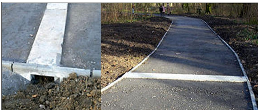
Photo 23 : Ecoduc de type "inférieur" pour les lombrics et autres invertébrés (= lombriduc. 9 ).
