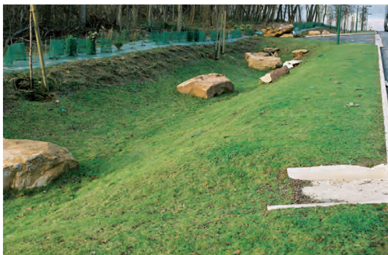
Noue engazonnée tondue
