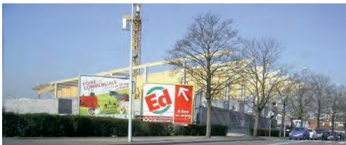
Nouvelle salle des sports Carnot/Gambetta en construction
