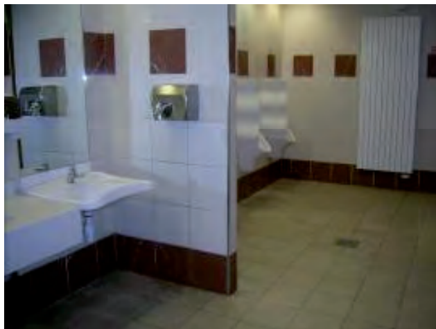
Extension d'Auchan (bâtiment ISO 14001) : récupération des eaux pluviales pour les sanitaires.
