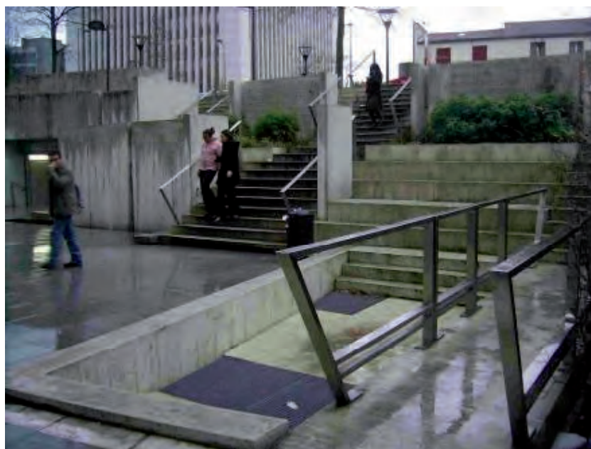
Place – aperçu des caillebotis d'accès au bassin enterré – partie inondable en bleu
