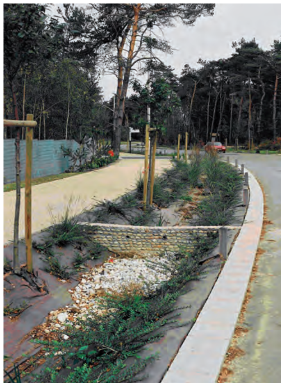
Les noues à redents optimisent l'infiltration
