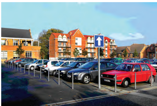
Chaussée réservoir avec caniveau de collecte et d'injection qui «organise» le stationnement
