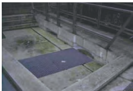
Entrée du puits marquée par un caillebotis.
