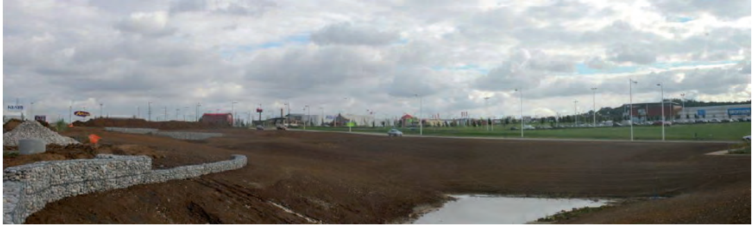
Travaux de terrassement de la coulée verte (2004).
