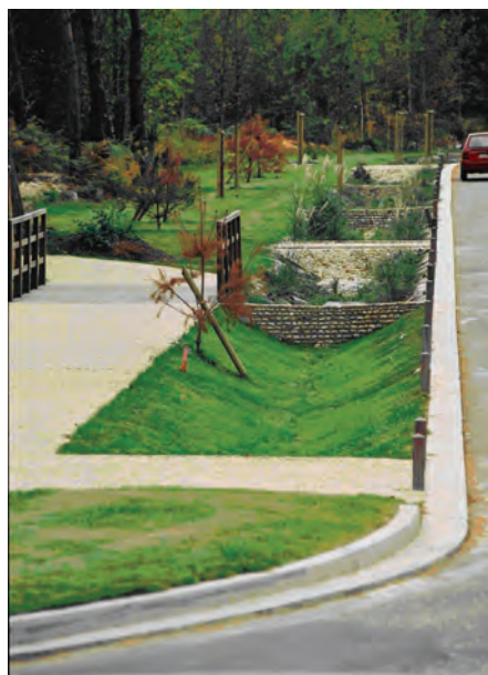
Noüe creuse, Technopole du Madrillet, St Etienne du Rouvray (76)
