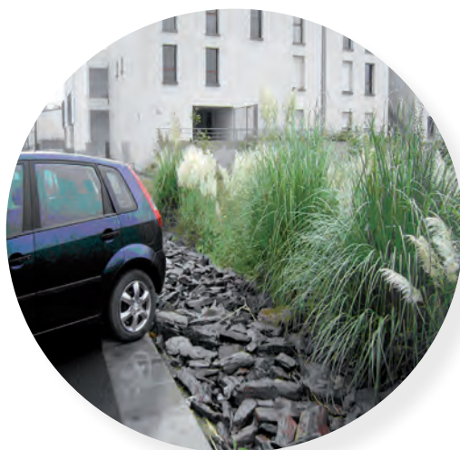
Tranchée d'infiltration remplie de schiste
