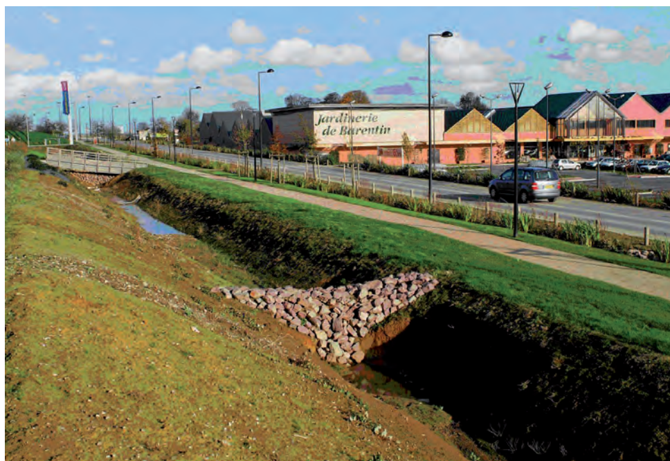
Noue à redents : phase chantier
