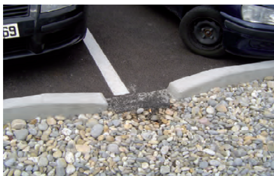
Détail des points d'alimentation de la rivière sèche
