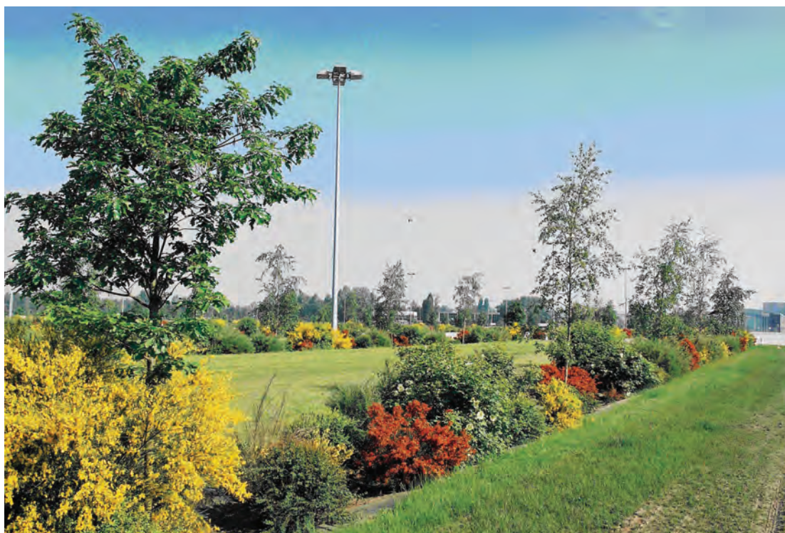
La conception de ce parking a conjugué stationnement, gestion des eaux pluviales (stockage, infiltration) et cadre paysager. ZENITH, Rouen (76)
