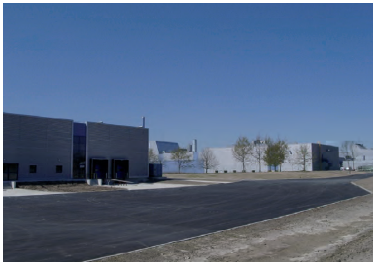
Exemple de noeue étanche à double usage : stockage des eaux pluviales des cours camions pour épisode pluvieux décennal et bassin incendie.
