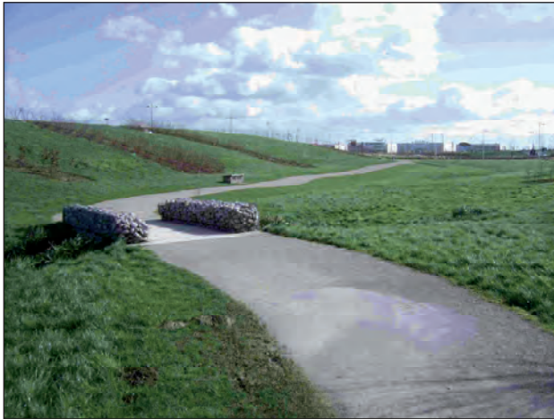
Equilibre des terrassements : trame verte en creux et coteau en remblai.
