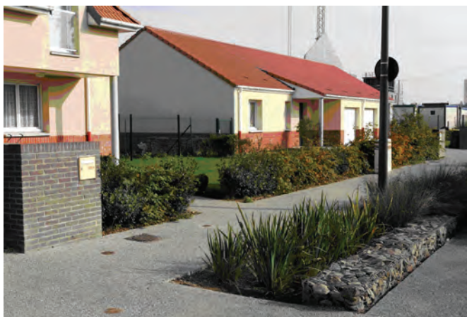
Espace vert creux avec gabions en soutènement et protection
