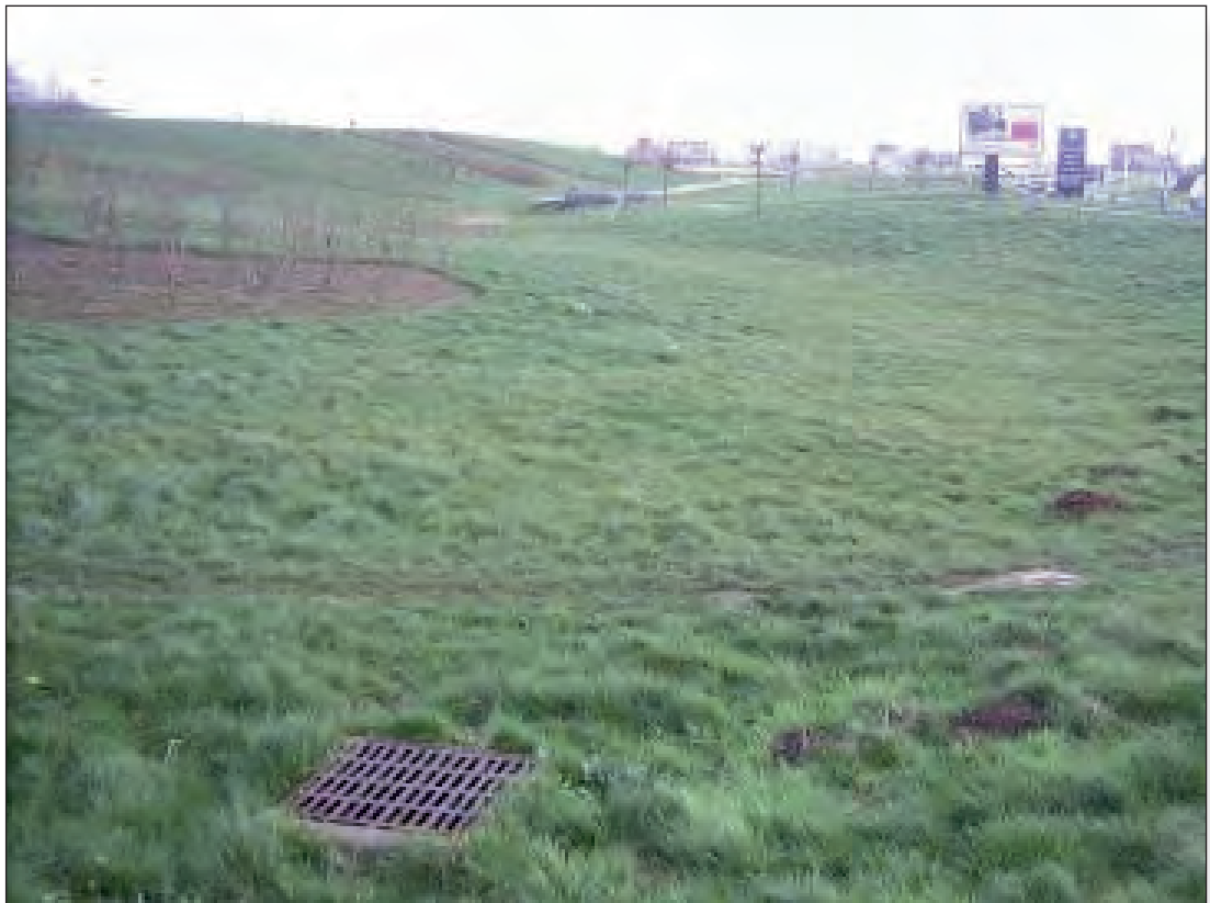
Grille de trop plein vers le réseau (fonctionnement rare).
