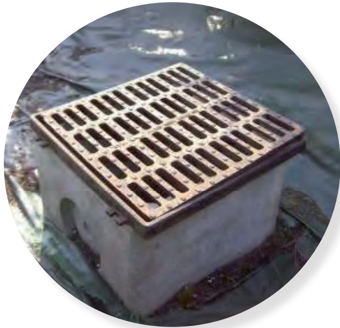
Grille - trop plein surélevée par rapport au fil d'eau de la noue
