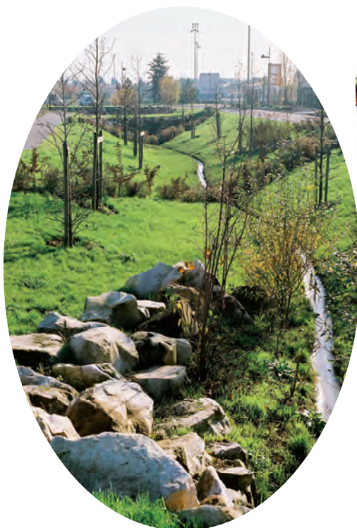
Noue engazonnée avec arbres d'alignement à moyen développement
