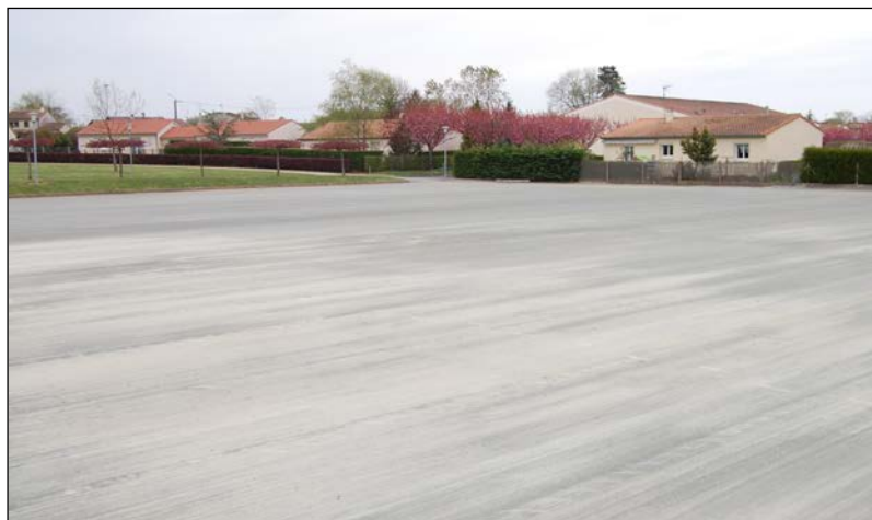
Terrain stabilisé de type sable de diorite granitique – Pompaire (79)
