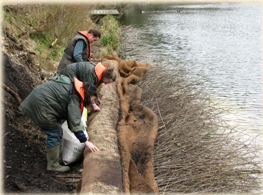
Fig. Etangs de ville d'Avray : montage et protection fascine
