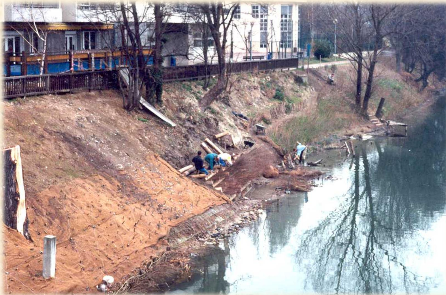
Fig. Issy-les-Moulineaux : 1 er ouvrage de génie végétal
