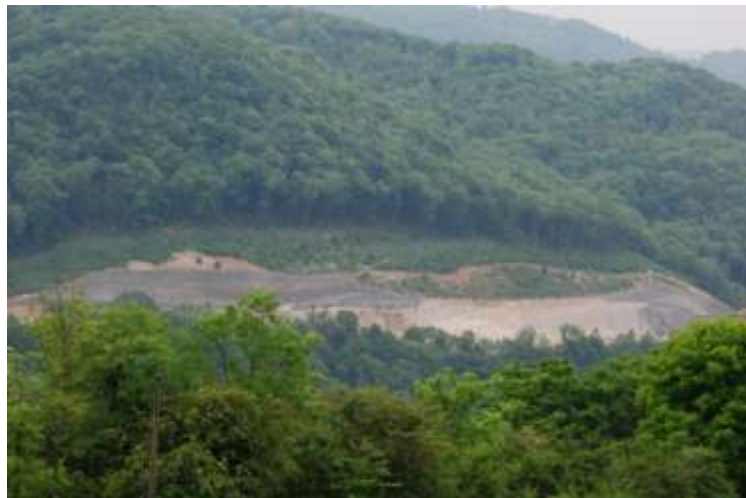
la future voie des Mercureaux
