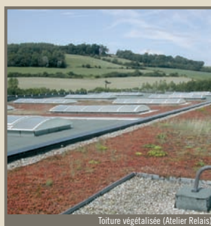
Toiture végétalisée (Atelier Relais)
